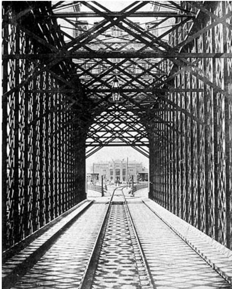
Widok z wnętrza mostu na wschodnią fasadę tczewskiego dworca.
