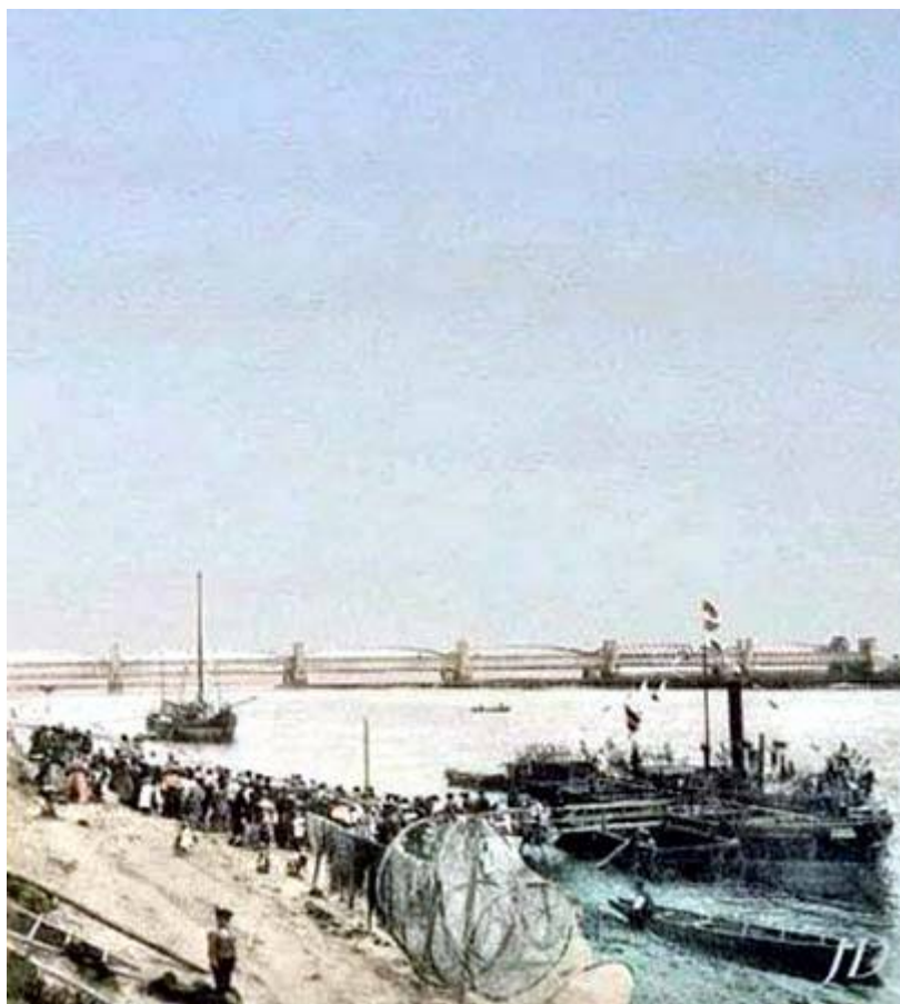
Mosty tczewskie z widocznymi bramami wschodnimi.
